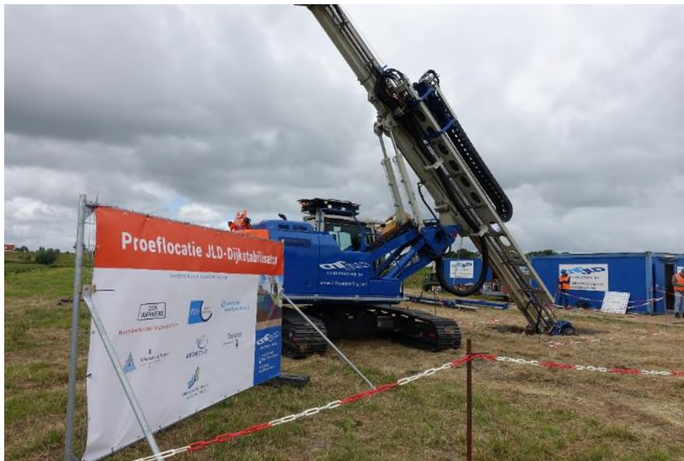
Figuur 4-11: Demonstratie plaatsing JLD-Dijkstabilisator in Purmerend op 22 juni 2018
