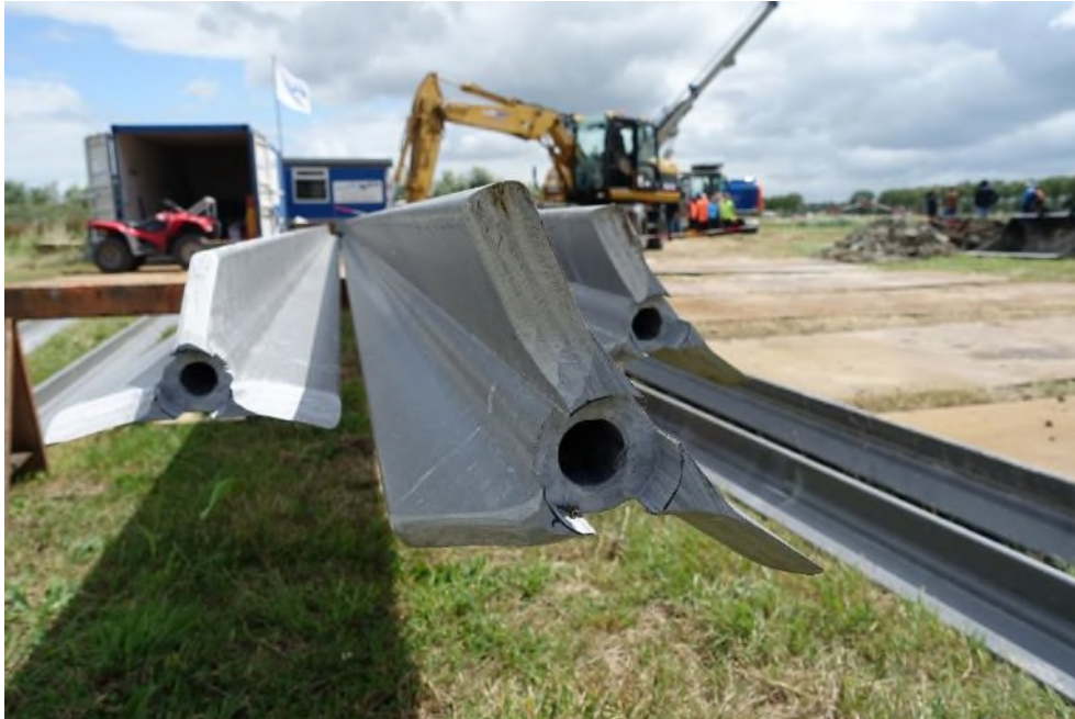
Figuur 4-15: LDE-element gezien vanaf het punt dat de grond ingaat
