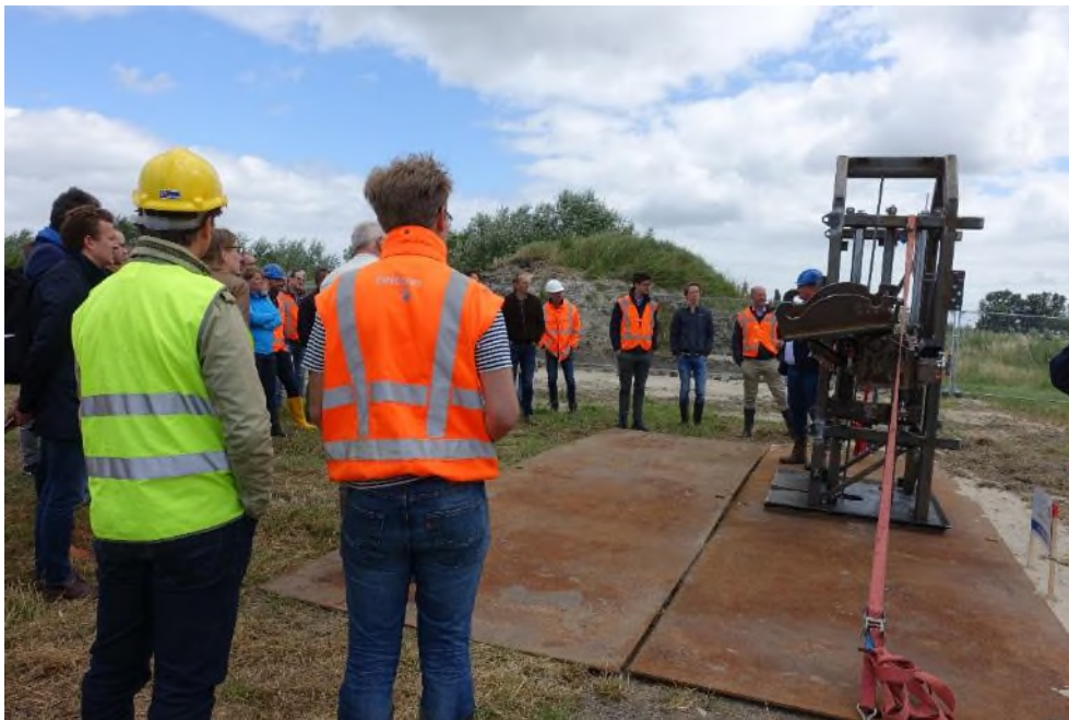
Figuur 4-13: Enkele van de aanwezigen bij de machine om voorspanning op de JLD-Dijkstabilisator te zetten
