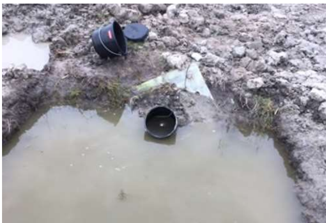
Figuur 3-3 Impressie schadebeeld.
