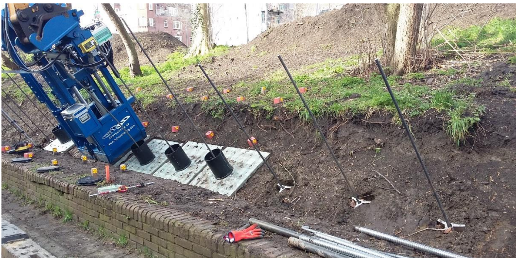
Foto 3-4: Afspannen JLD-Dijkstabilisatoren pilot Watergraafsmeer.
