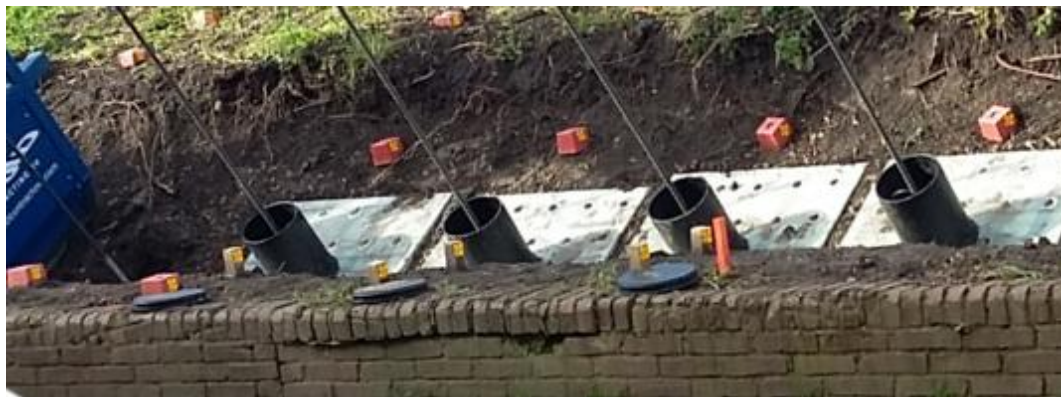
Foto 3-5: Kopplaten van links naar rechts; Aangespannen kopplaten 303, 304, 305, 306. Kopplaat 308 wordt afgespannen
