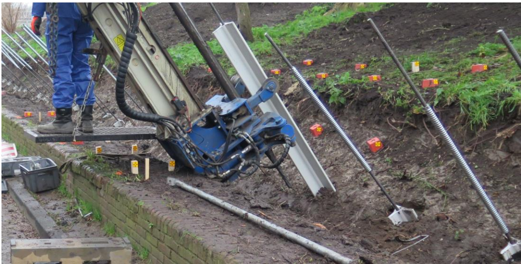
Foto 3-3: inbrengen JLD-Dijkstabilisator pilot Watergraafsmeer.
