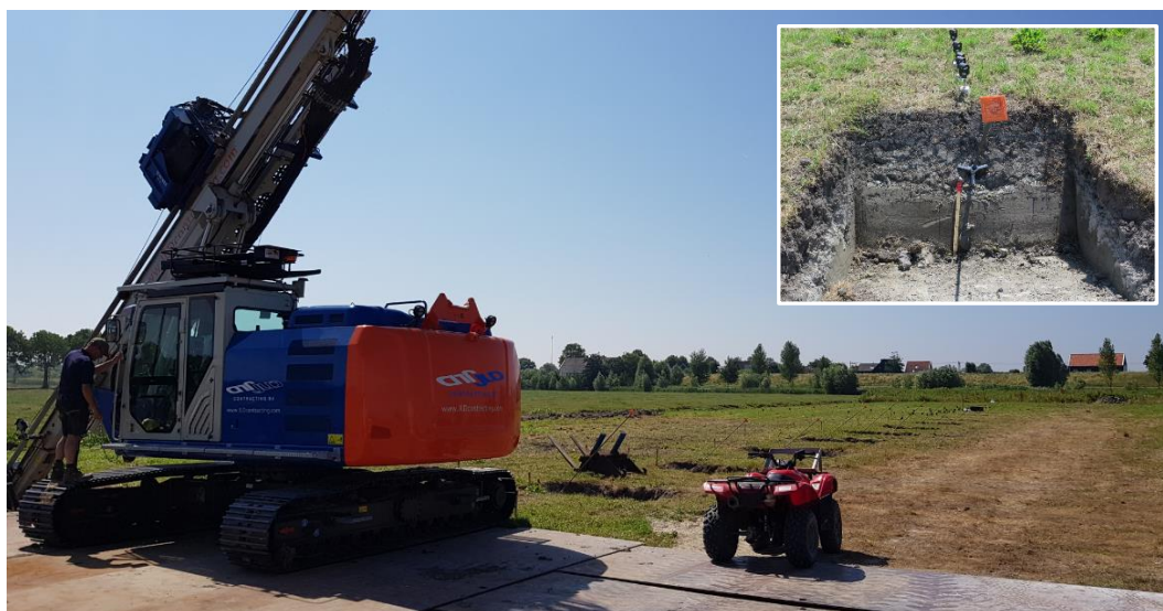
Foto 2-1: inbrengen JLD-Dijkstabilisator op proefveld Purmerend, rechtsboven detail van ingebrachte JLD-dijkstabilisator nog zonder kopplaat
