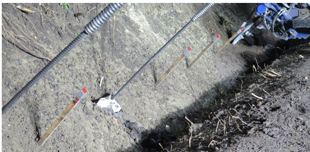
Foto 3-1: JLD Dijkstabilisatoren, links naar rechts, 308, reeds geplaatst 307, 306, 305, 304 en 303 tpv ankermachine
