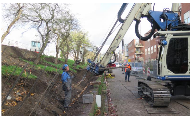
Foto 4-3: JLD ankermachine met daarvoor de graafmachines
