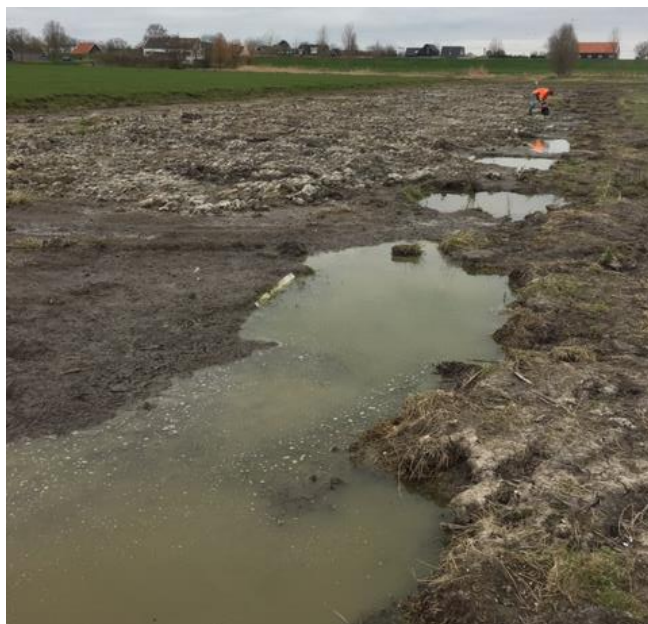
Figuur 3-6 Impressie schadebeeld (2-3)
