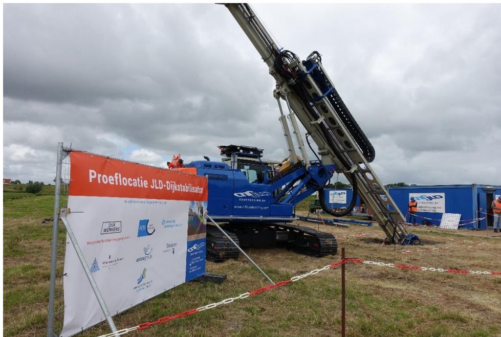
Figuur 3-1: Demonstratie plaatsing JLD-Dijkstabilisator in Purmerend op 22 juni 2018
