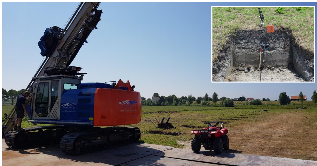
Foto 2-1: inbrengen JLD-Dijkstabilisator op proefveld Purmerend, rechtsboven detail van ingebracht JLD-dijkstabilisator nog zonder kopplaat
