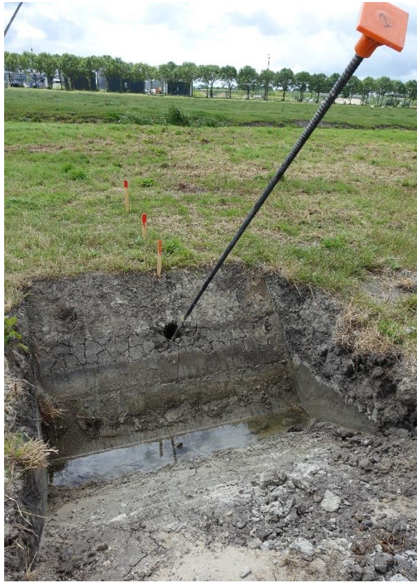
Figuur 3-4: Proefopstelling JLD-Dijkstabilisator in Purmerend (foto 22 juni 2018). Zichtbaar is het gat van de drijfstang en de trekstang daarin. Het LDE-element is niet aangebracht. Het zichtbare water is freatisch grondwater.
