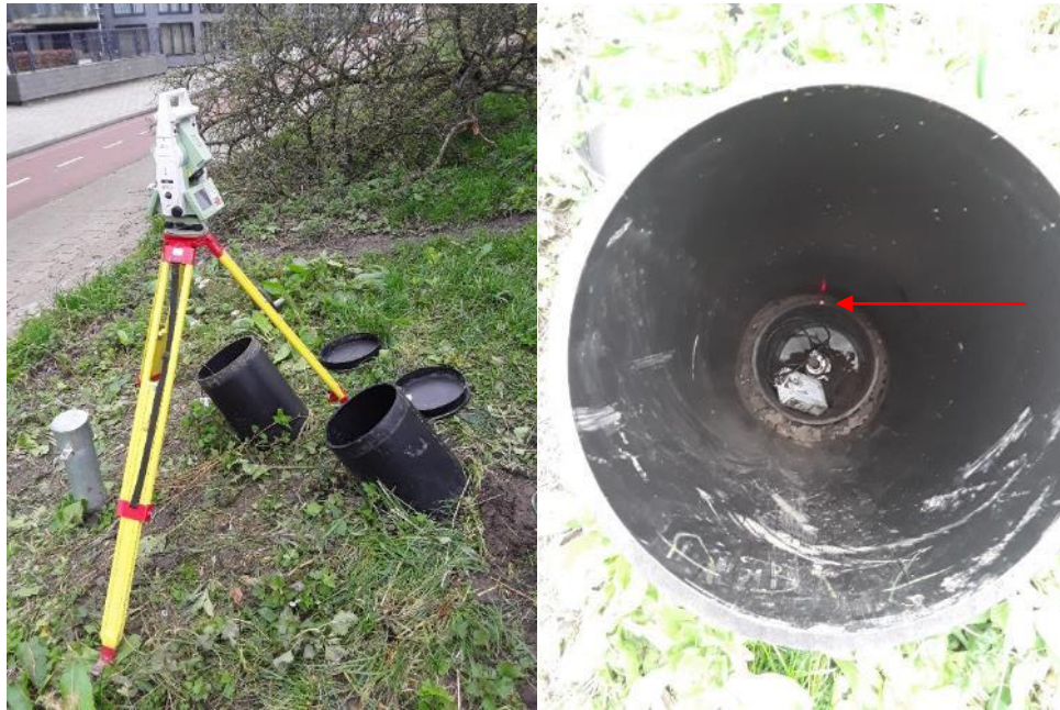
Figuur 4-3 Foto's meetopstelling (links) en de locatie van het meetpunt, zichtbaar door de rode licht van de laser (rechts)
