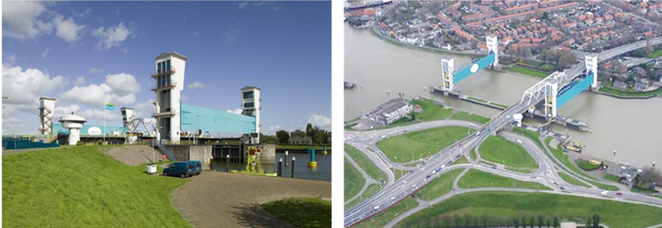
Figuur 4.2 Stormvloedkering in de Hollandse IJssel (Algera kering bij Capelle a/d IJssel)
