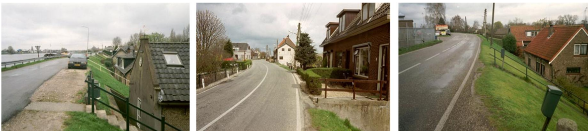
Figuur 2.2 Veel bebouwing met name op binnentalud en binnendijks
