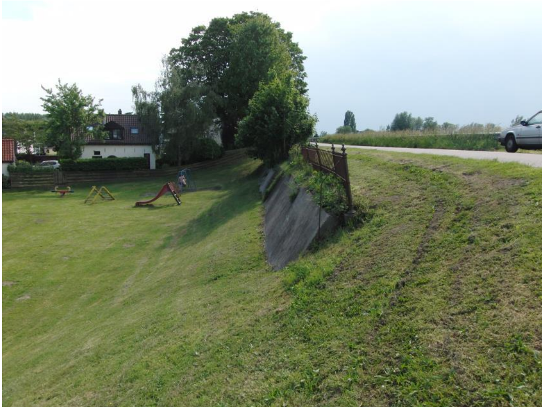
Figuur 6.10 Keermuur bij 33.46 in huidige staat (Foto zomer 2015).
