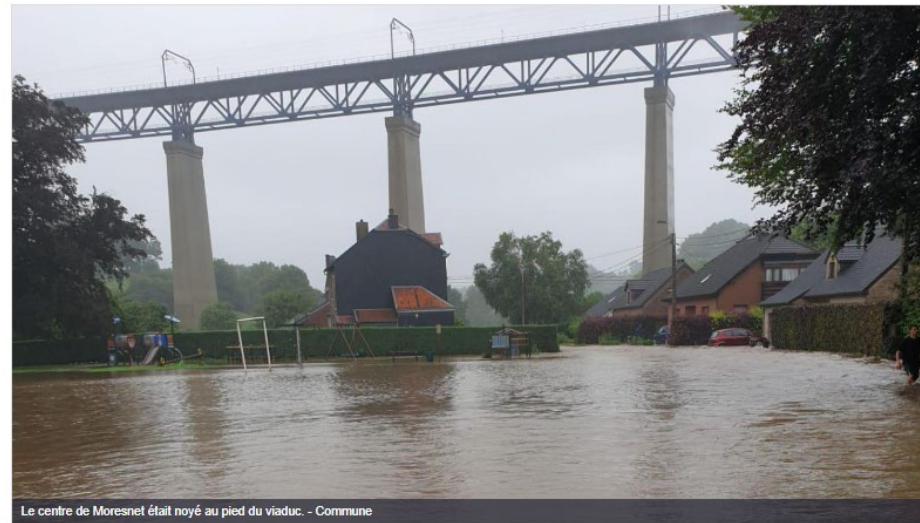
Le centre de Moresnet était noyé au pied du viaduc. - Commune
