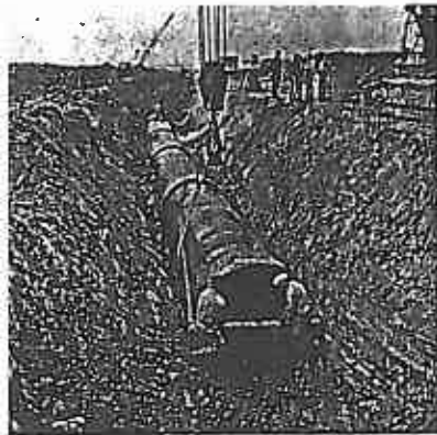
Voorbeeld 4 Voorgespannen betonnen buis met rubberingverbinding.
