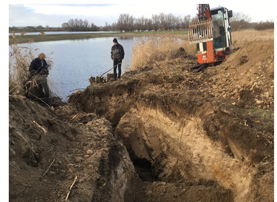
Uitgegraven beverhol in de IJsseldijk (foto: WDOD).
