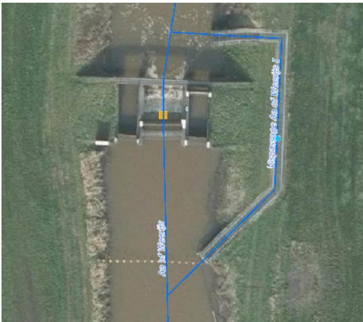
Figuur 4-8 luchtfoto van stuw Bakkebrug (KST00561) met van links naar rechts: een 2,5 m brede schuif met kruinhoogte ruim boven bovenstrooms streefpeil, een 5 m brede kantelstuw die bovenstrooms peil regelt o.b.v. een bovenstrooms meetpunt, een 2,5 m brede schuif met kruinhoogte ruim boven bovenstrooms streefpeil, een De Wit vispassage waardoor 10% van het debiet gaat bij een voorjaarsafvoer/gemiddelde afvoer.
