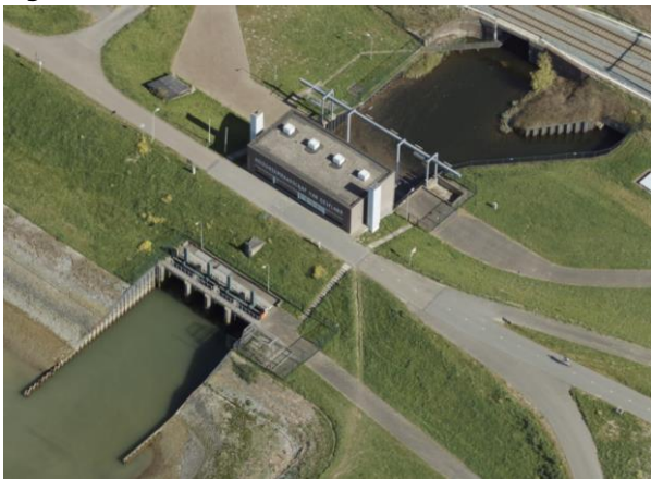
Figuur 6-2: Gemaal Westland
