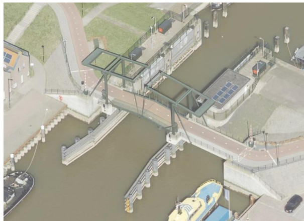
Keersluis Gemeentehaven Maassluis
