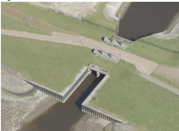
Figuur 6-3: Spuisluis Boonerhaven
