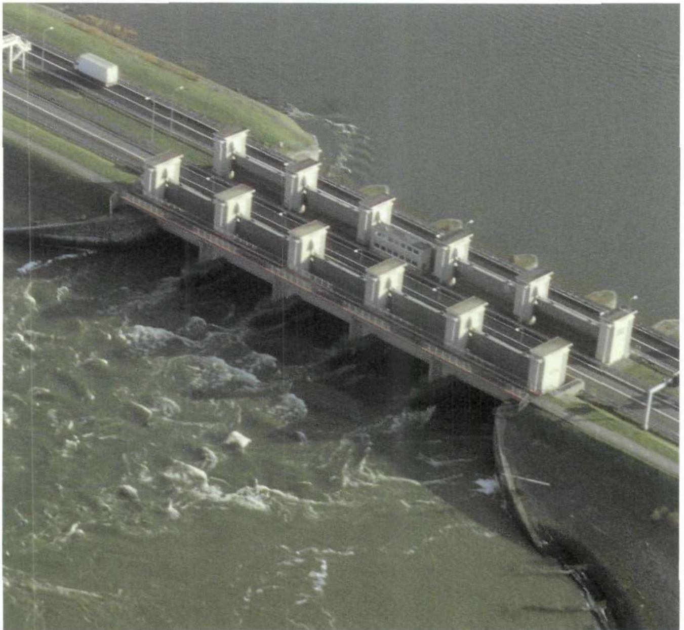
Via de spuisluizen bij Kornwerderzand en bij Den Oever stroomt het IJsselmeerwater tijdens eb onder 'vrij verval' naar de Waddenzee.
