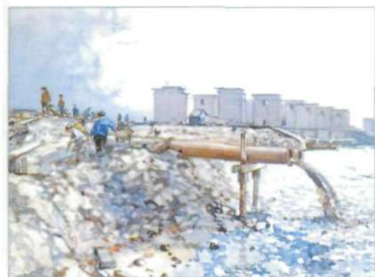
Aanleg van de spuiscuizen in Afsluitdijk, 1931. Aquarel van J.H. van Mastenbroek.
