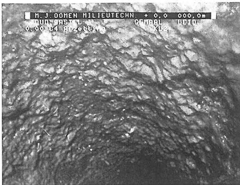
Foto 3: Dikke slijmlaag in een \varnothing 450 mm AC buis
