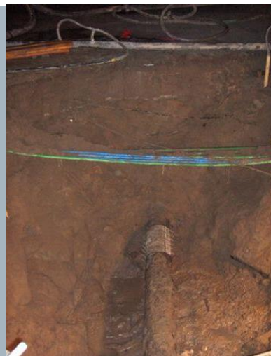
Gij 350 leiding met reparatieklem
