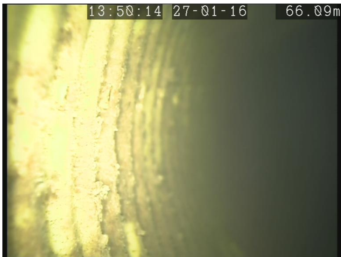
Figuur 2.25 Foto van de inspectie vanuit de water inlaat.
