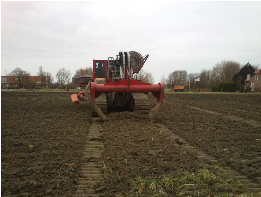
Figuur 2.6 Aanleg van de peilgestuurde drainage.
