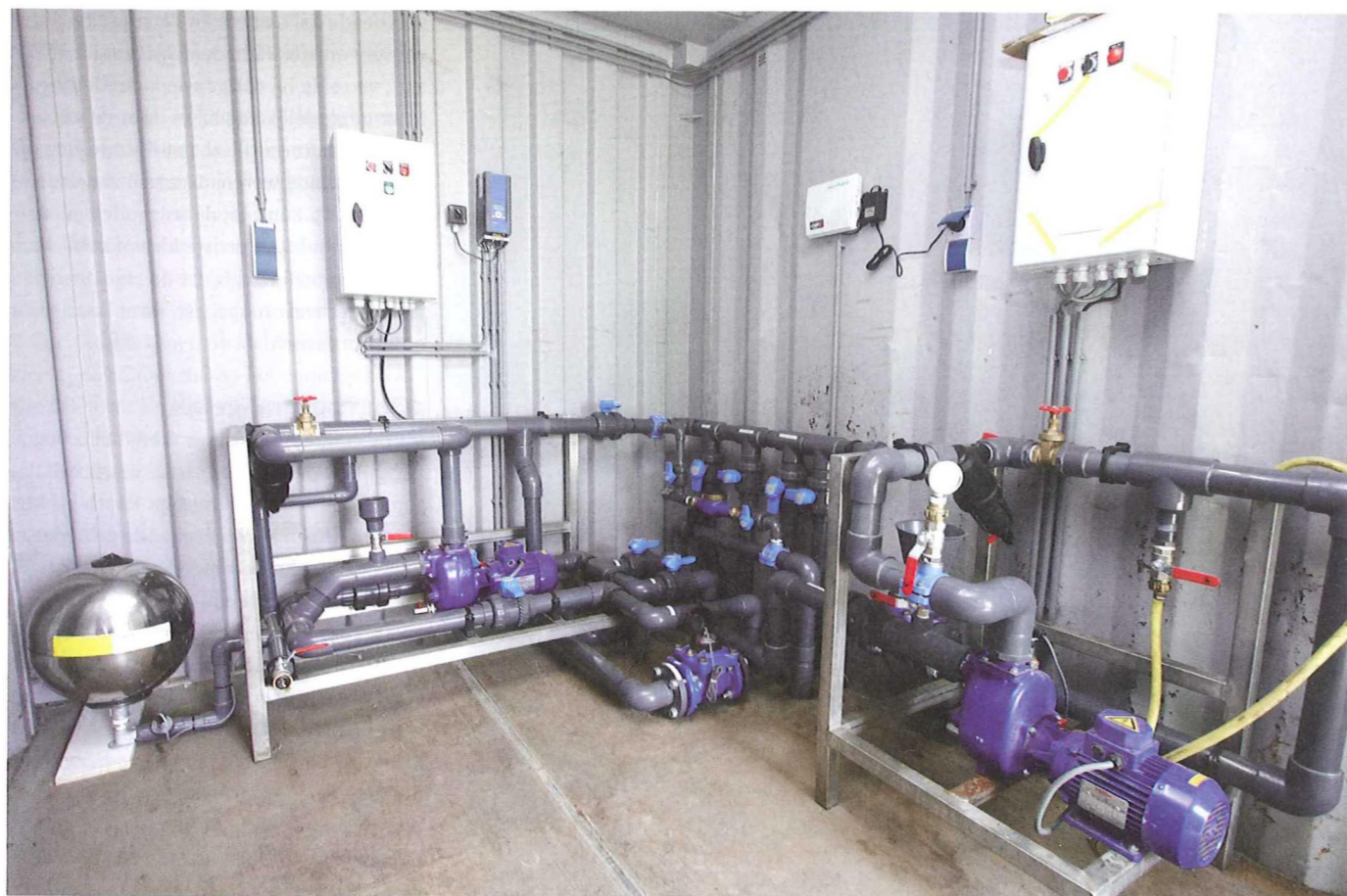
De opstelling van de zoet- en zoutwaterpompen van de Freshmaker (links de zoetwaterpomp).
