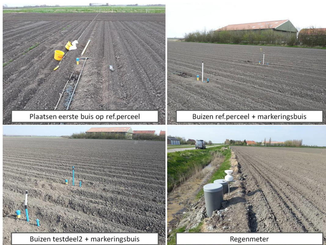
Figuur 4.8 Installatie van de peilbuizen op 2 mei 2013. De regelputten zijn zichtbaar en regenmeter zijn zichtbaar op de foto rechtsonder.
