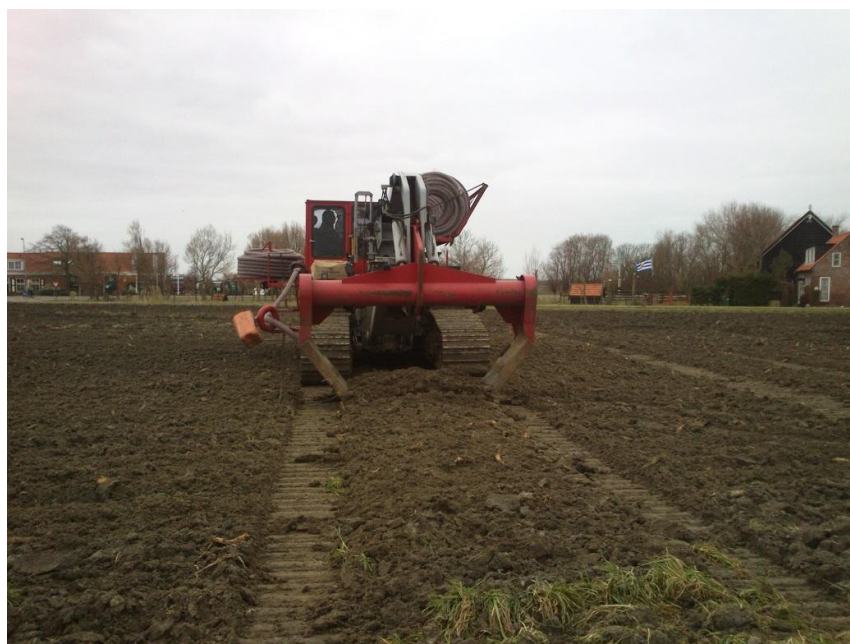
Figuur 2.6 Aanleg van de peilgestuurde drainage.
