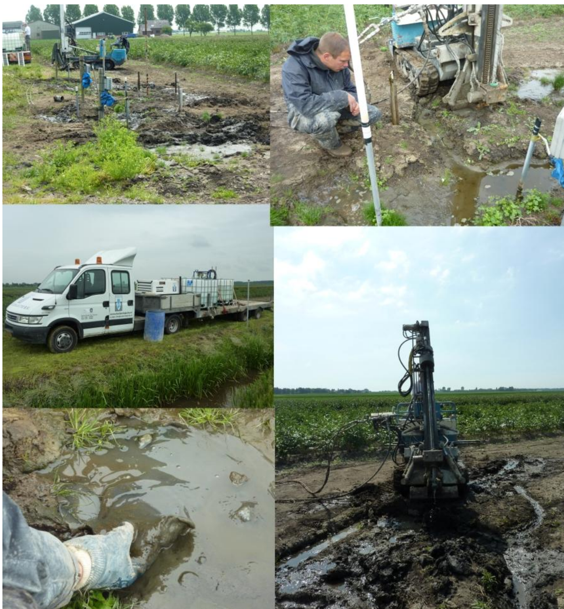
Foto's: Het dichten van wellen op locatie A. Het injecteren van de dichtingsvloeistof gebeurt met een rupsvoertuigje. Linksonder, de uitgeharde injectievloeistof
