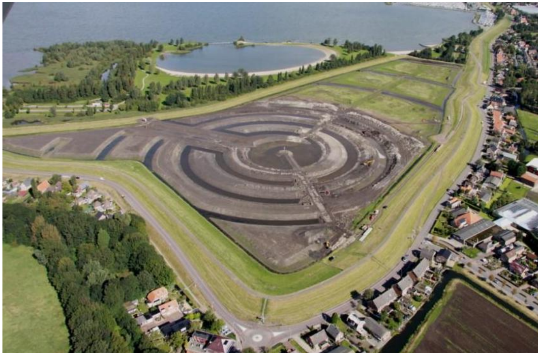
Figuur 2.3 Koopmanspolder in 2012 tijdens de aanleg van de ringvormige sloten
