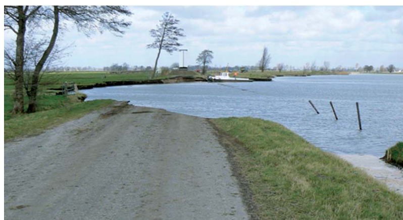
Figuur 15 Oeverinscharing door bresvloeiing in zandwinning 2008.
