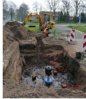
Kogelkopkraan en automatische ontlufter op rioolwaterpersleiding HDPE 4500
